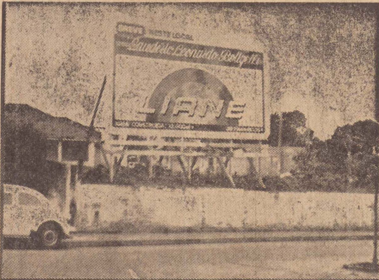
EDIFÍCIO LAUDERIO LEONARDO BOTIGELI — O Grupo Liani, iniciou a construção do edifício que será um dos mais altos de Presidente Prudente. Na
