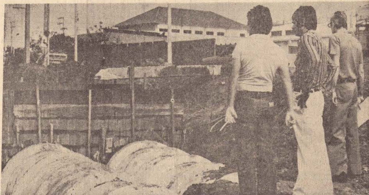
Em companhia de assessores, o prefeito inspeciona a conclusão das obras da galeria que canalizou o Corrego do Veado, entre a Av. Brasil e a Av. Cel. Marcondes
