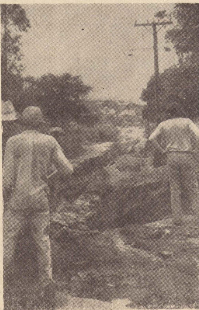
Os tubos já estão assentados na rua D. Pedro II, faltando apenas a recuperação do leito, o que se dará na proxima semana
