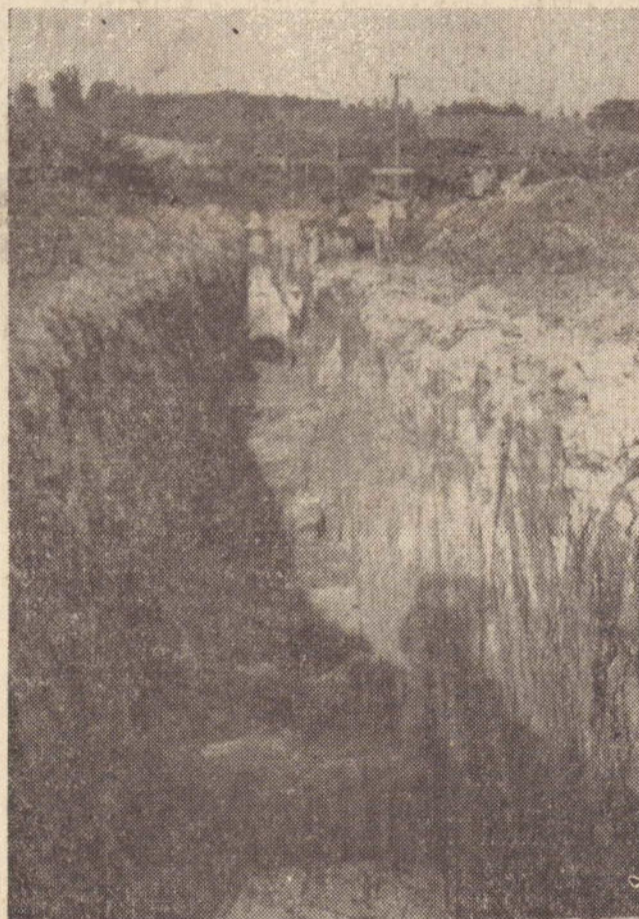
As valetas abertas pela Prefeitura para receberem as tubulações de 1m de diametro, na rua 17, do Parque Furquim
