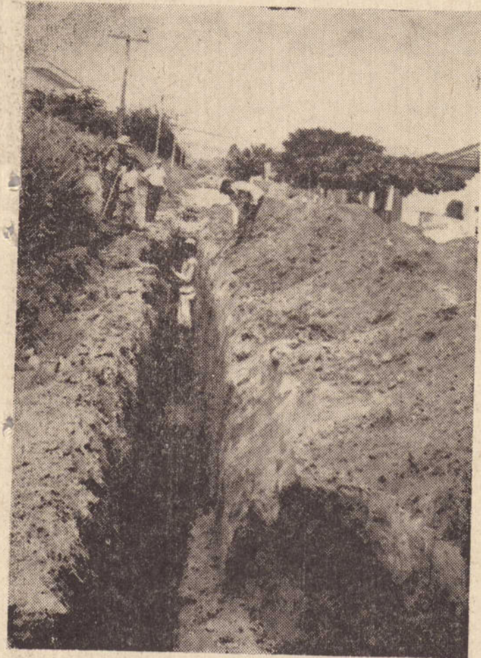
Um aspecto das obras que o DAE vem realizando na antiga rua Avaré no Jardim Paulista
