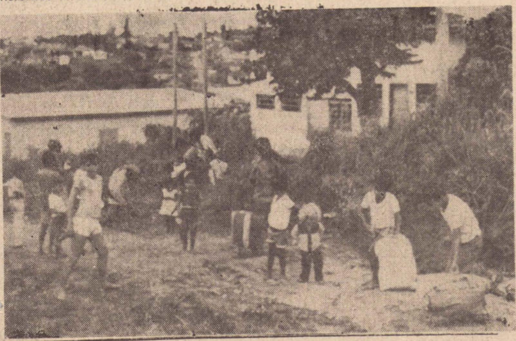
As primeiras famílias de desocupados começaram a ser desalojadas das casas em ruína no Jardim Bongiovani.
