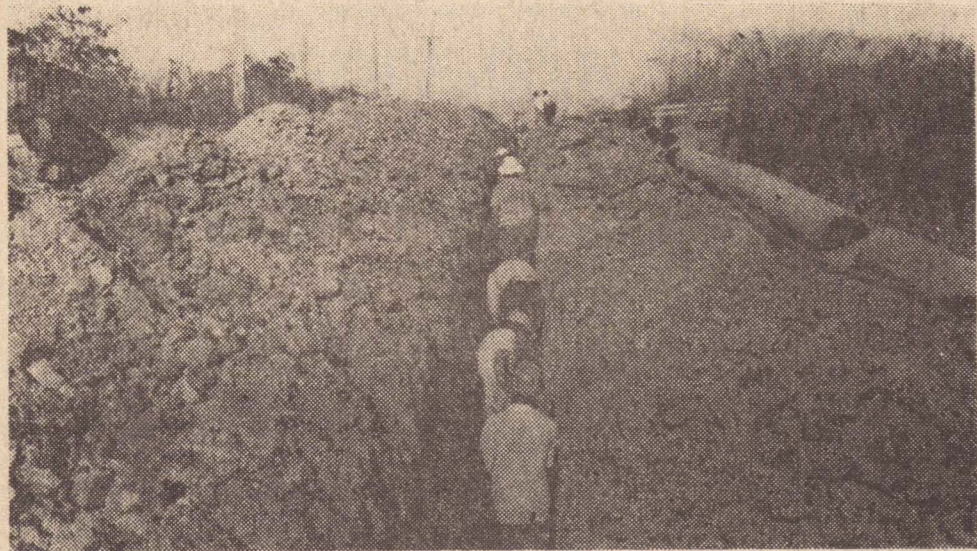
Com a extensão dessa rede para abastecer uma sub-adutora, toda a região sul da cidade será beneficiada.
