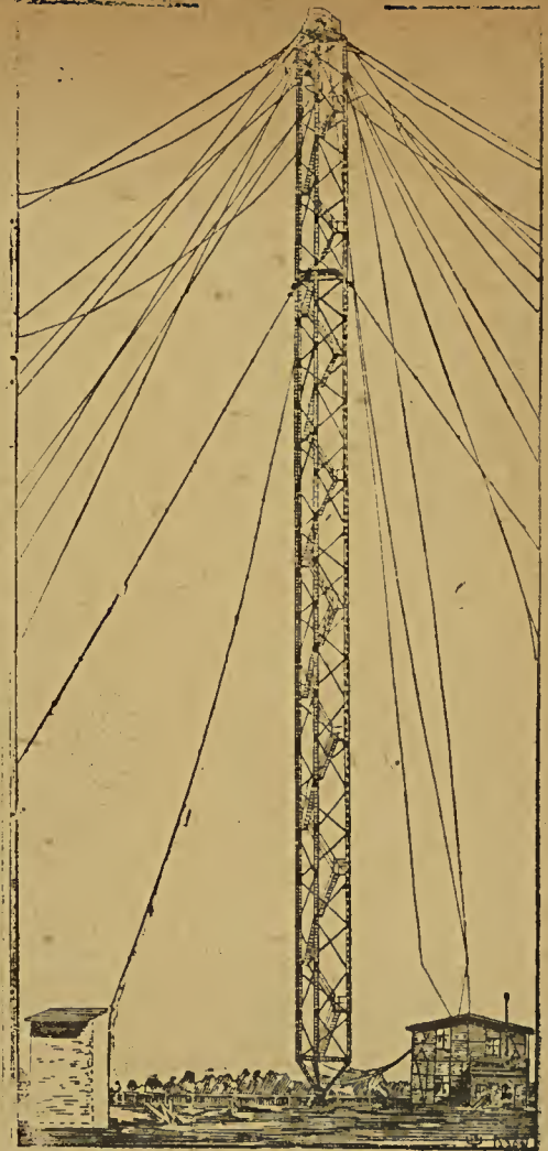
Station für drahtlose Telegraphie in Rauen. Die hier befindliche große Telefunkenstation hat einen kolossalen Erfolg zu verzeichnen, indem sie auf eine Entfernung von 3700 Kilometern mit dem Dampfer „Cap Blanco“ in Santa Cruz (Teneriffa) Telegramme wechselte.
