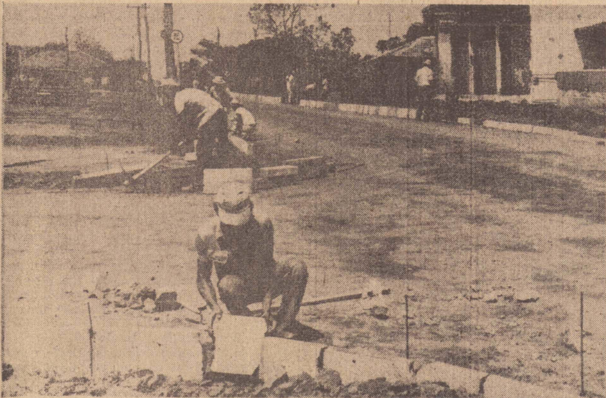
Ruas dos distritos estão recebendo a pavimentação
