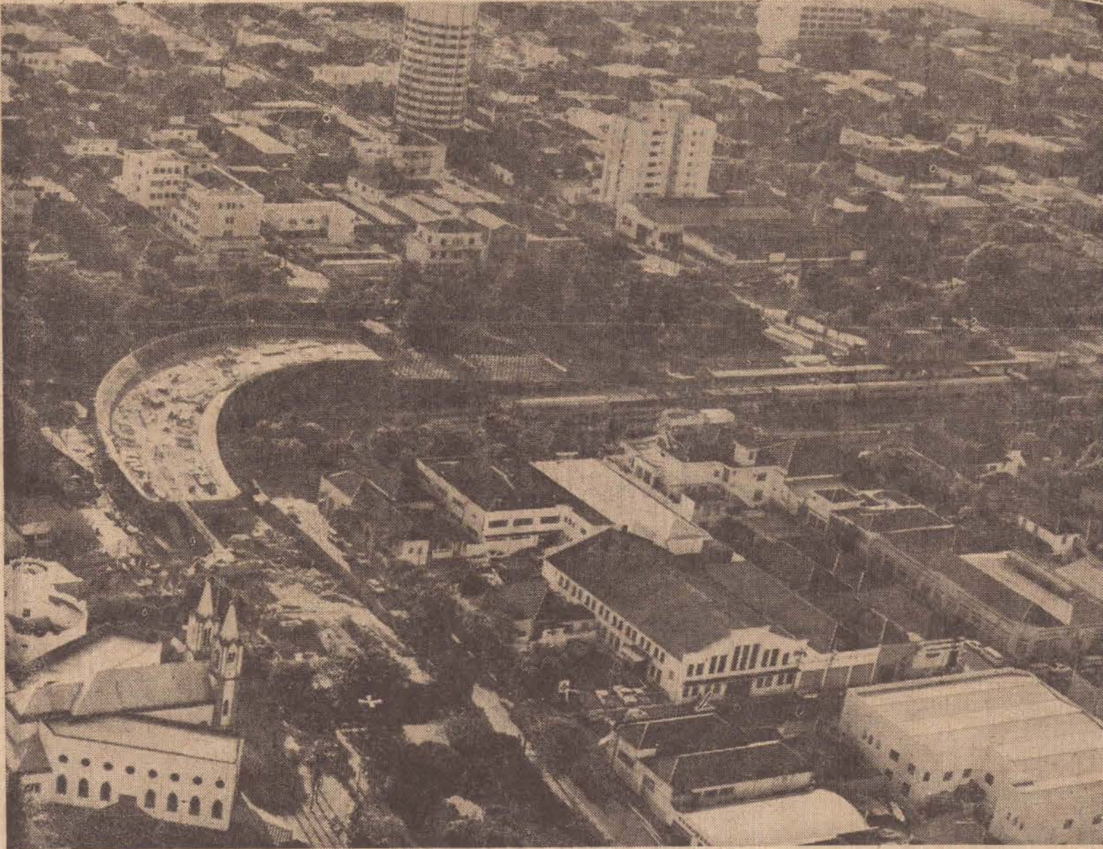
Nesta vista aérea, ainda que com 60% de sua obra concretada, uma visão do viaduto da Maffei.
