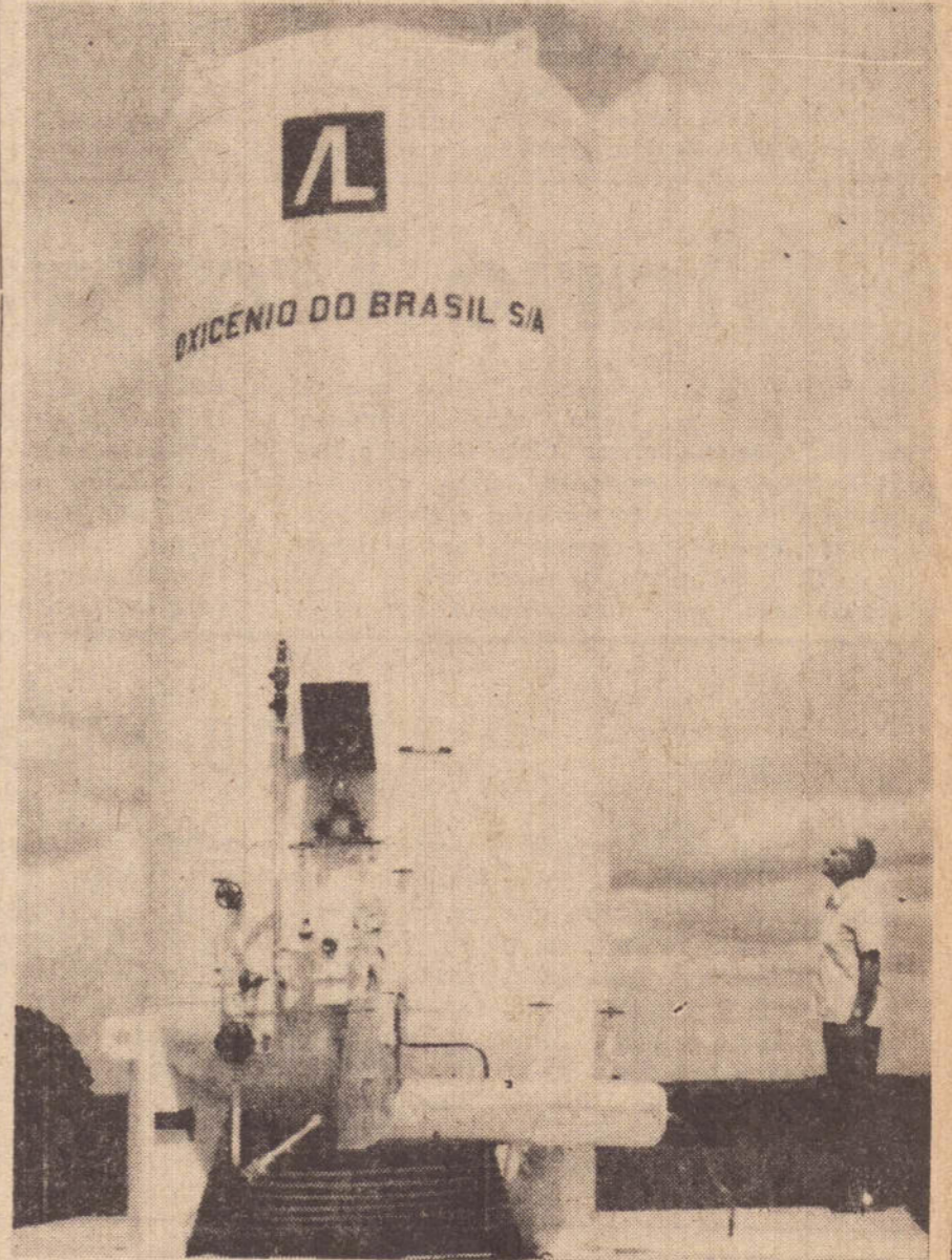
Vista do enorme tanque especial, depósito de Nitrogênio Líquido, único no gênero em nossa Região.
