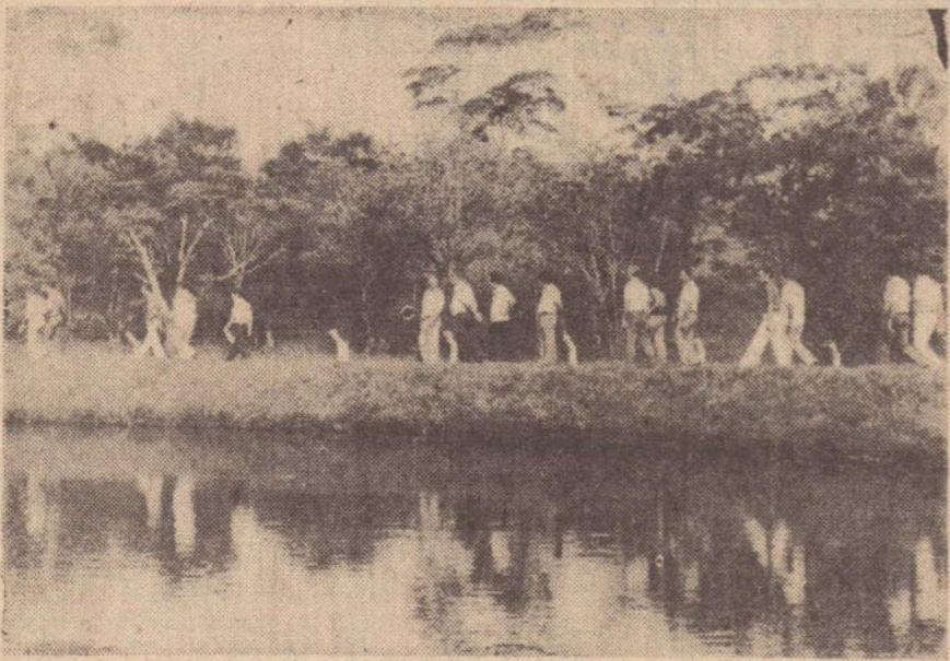
A moderna lagoa de captação e tratamento.
