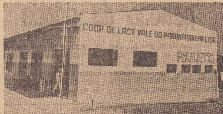
Vista das novas instalações
