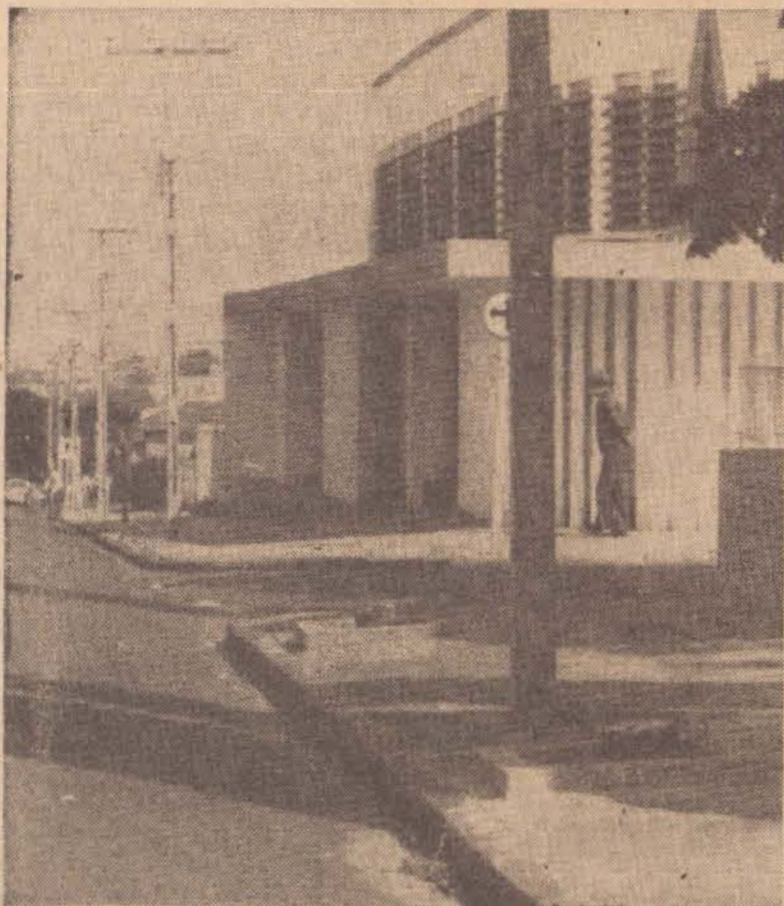
Éis o que restou de duas frondosas árvores existentes na esquina da R. 7 de Setembro, com a R. Prudente de Moraes
