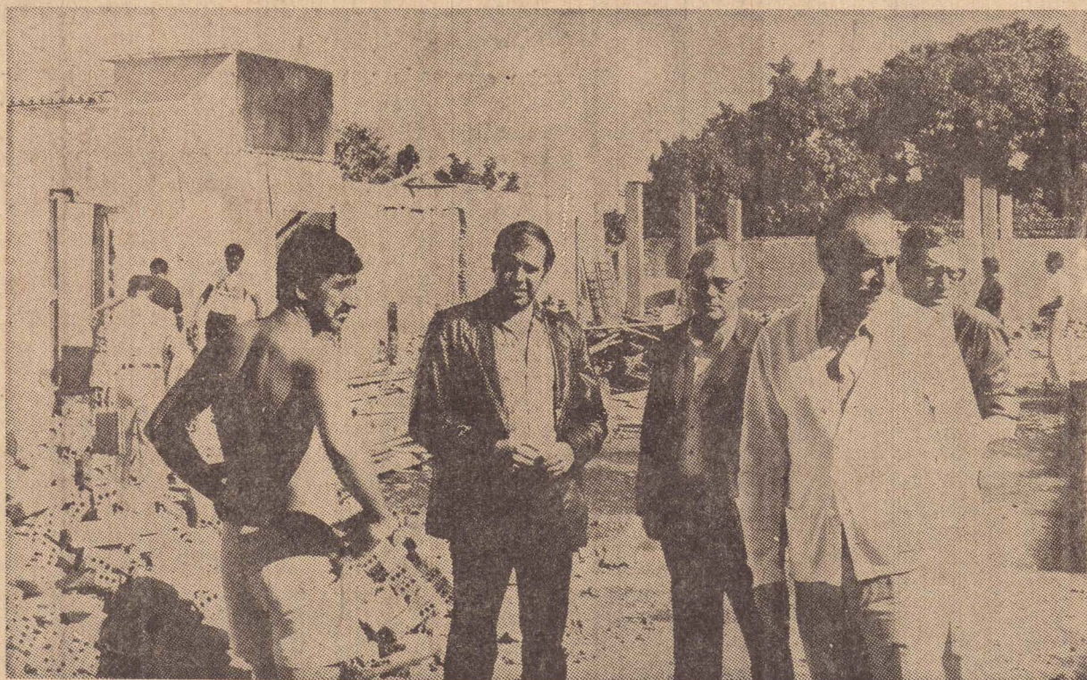
O prefeito visita a área de demolição do quartel dos Bombeiros.
