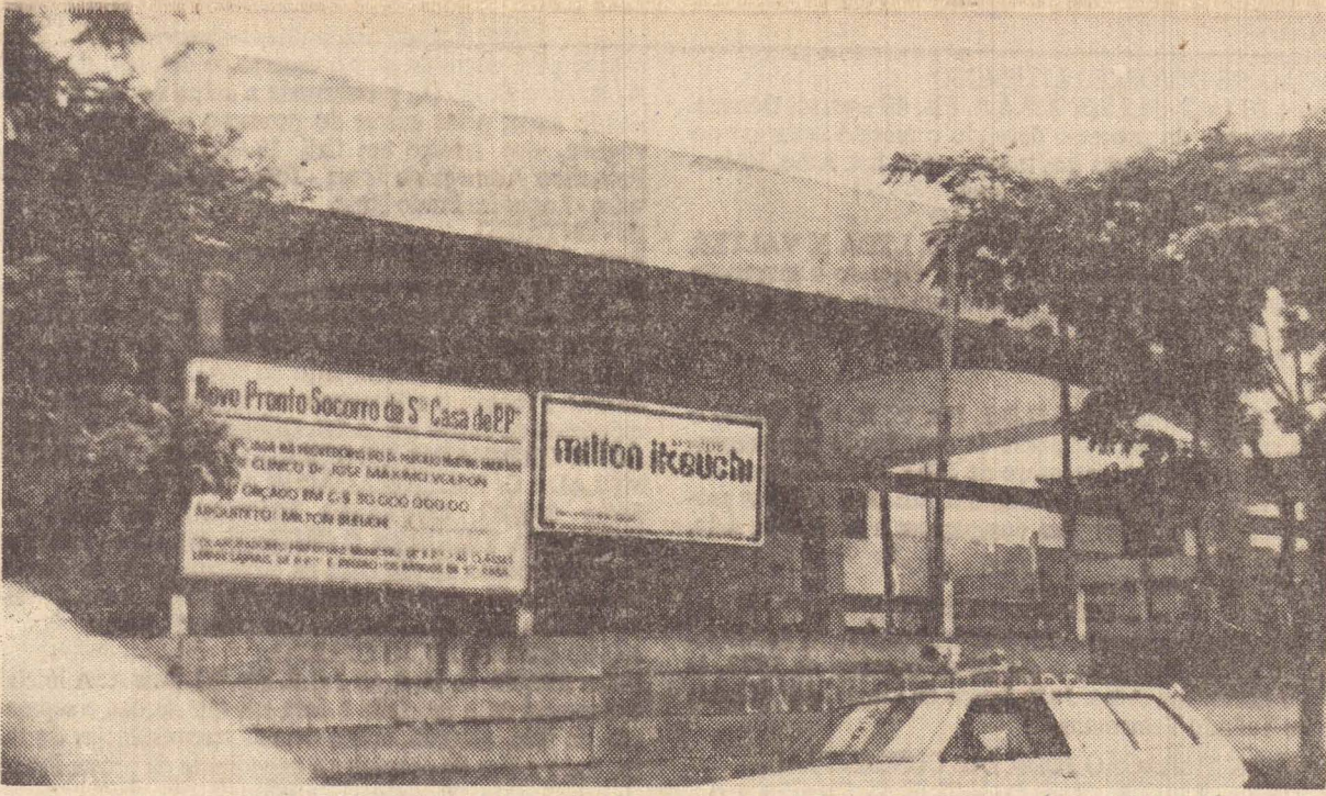
No dia 28 de agosto de 1982, foi lançada a pedra fundamental e exatamente um ano após, o prédio está quase pronto.
