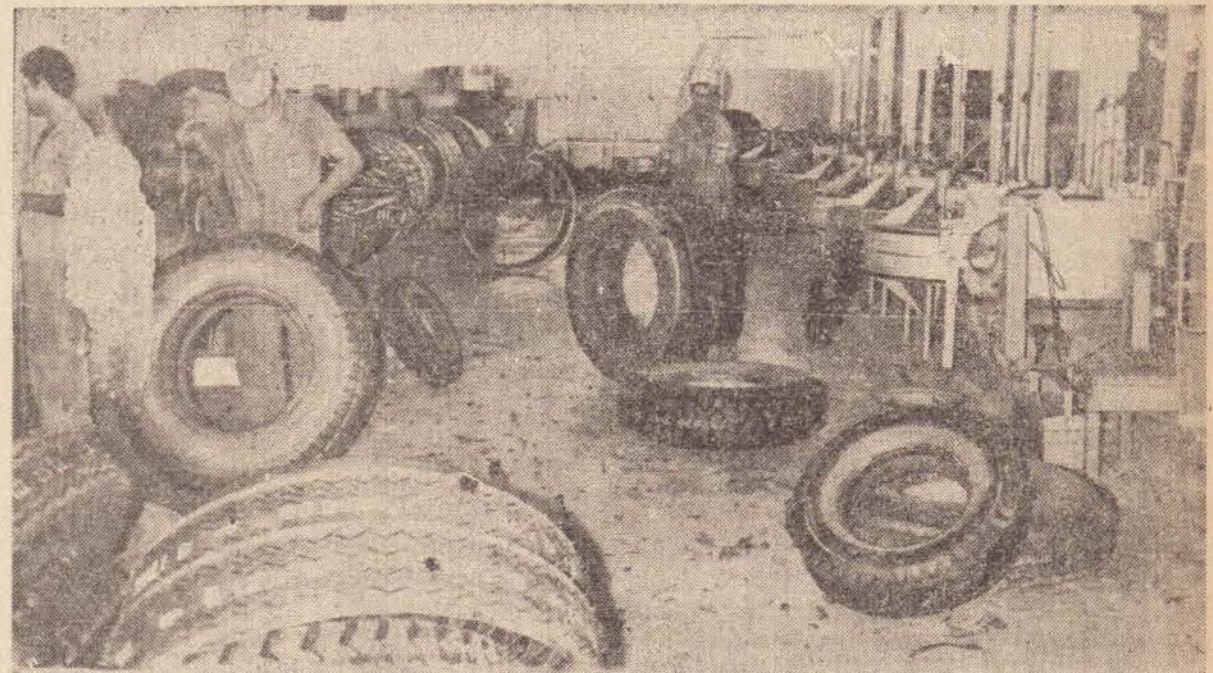
Feito o processo de aplicação de colagem, e depois do tempo exigido para que se dê a consistência exigida, com o pneumático inflado faz-se a roletagem, ou seja, a afixação da borracha na carcaça do pneu. A demonstração, nessa foto, está sendo assistida pelo encarregado geral do departamento de Caiado Pneus, número 13, e com a presença do Dr. Deodato da Silva, diretor administrativo do Jornal.
