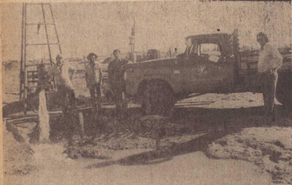
Um dos últimos poços semi-artesianos deu uma vazão de 113.000 litros/h, sendo contratado pelo Frigorífico União S/A., em Pres. Epitácio.
