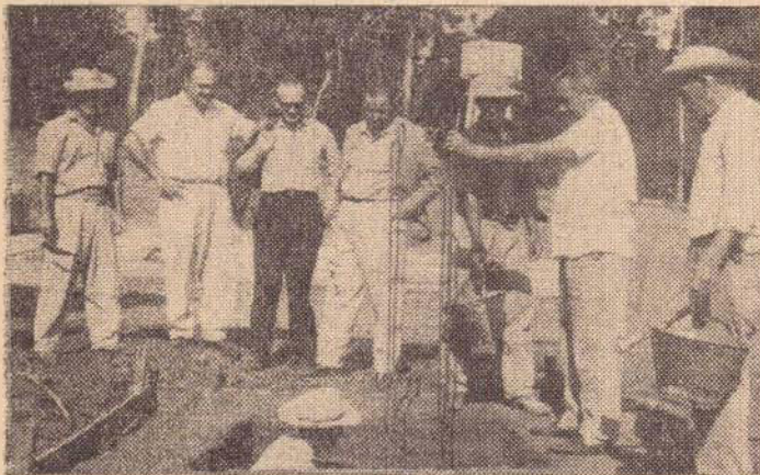
Primeira sapata e coluna, sendo concretadas. O Dr. Palhano, Engo. da obra, inspeciona os trabalhos. Ao fundo o Presidente do Clube ladeado por mais dois diretores.
