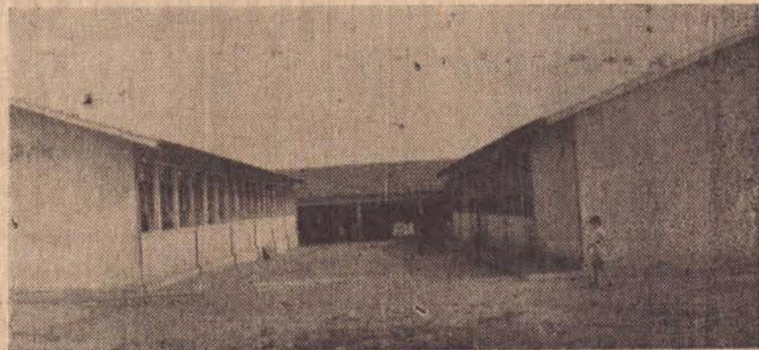
Perspectiva dos dois pavilhões do Grupo Escolar «Ana Rita de Cássia», observando-se ao fundo o grande abrigo que os une.
