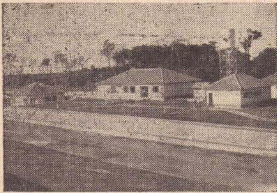
Vista do conjunto onde funciona o Escritório do Armazém, a usina elétrica motorizada, o chuveiro dos ensacadores e a residência do Fiel.
