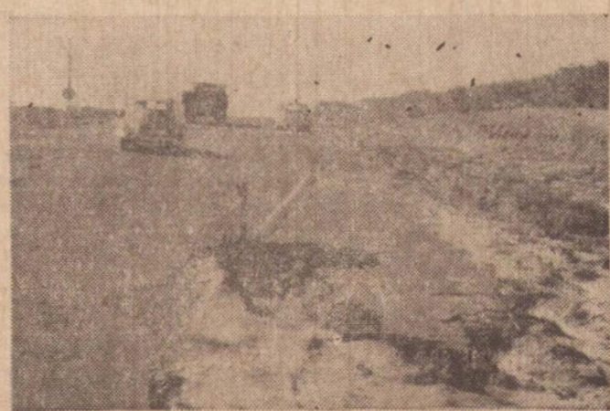
O asfalto está se decompondo nas estradas.
