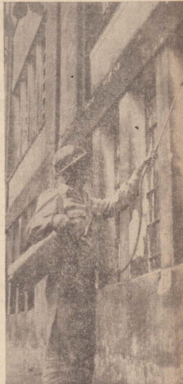
INSETOS ATACADOS, AULAS SUSPENSAS
