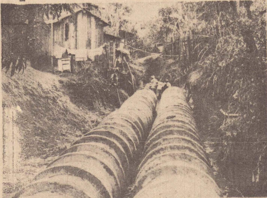
Na Vila Líder a prefeitura constrói uma galeria de aproximadamente 3 mil metros
