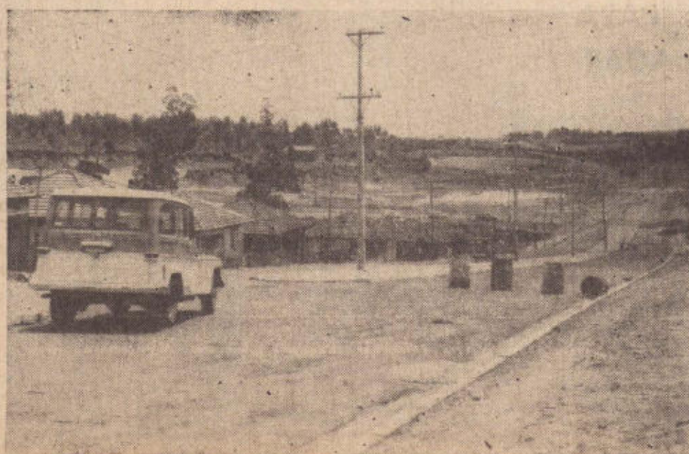
Pésima sinalização da Av. Manoel Goulart causa acidentes.
