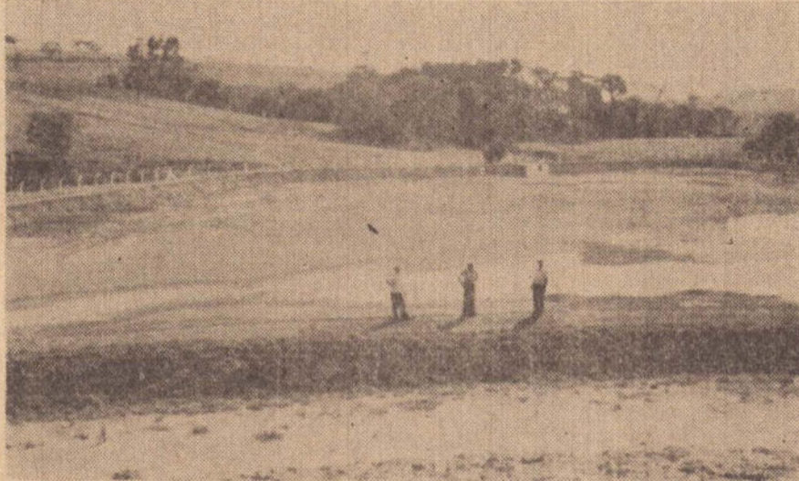
Um aspecto da lagoa de tratamento do esgoto de Alfredo Marcondes
