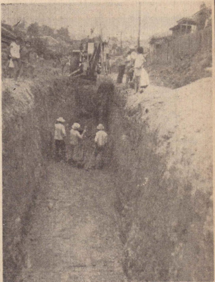
As obras de canalização na rua Xingu, resolverão um velho problema de inúmeros moradores daquela artéria
