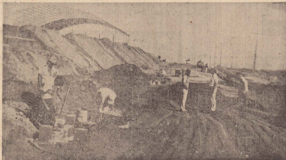
Operários trabalhando na construção de uma boca-de-lobo, tendo ao fundo o pavilhão industrial das Bebidas Asteca, em execução no DI
