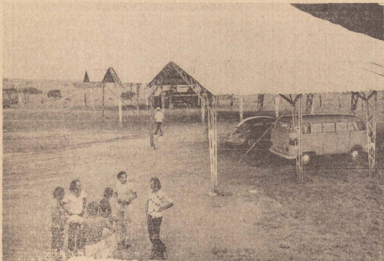
Alguns pavilhões já estão montados e prontos para receber o gado.
