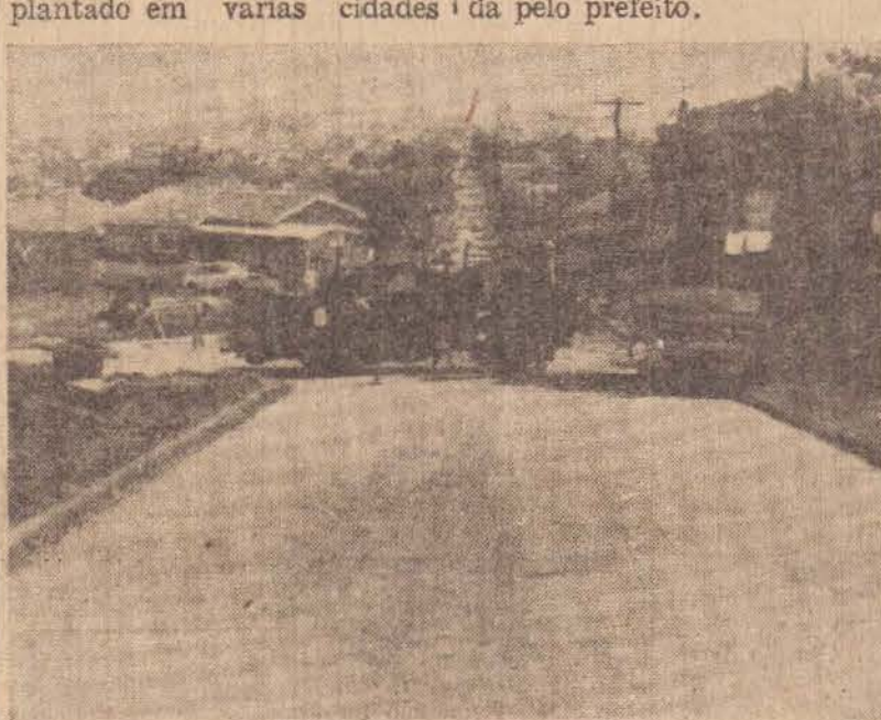
O novo aspecto urbanístico do Jardim Estoril, após receber a pavimentação.
