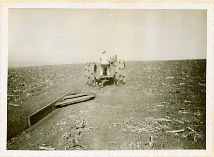
Terraceamento com prancha de madeira. O serviço fica pronto com 5 passadas.
