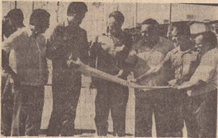
O prefeito acompanhou pessoalmente o início das obras
