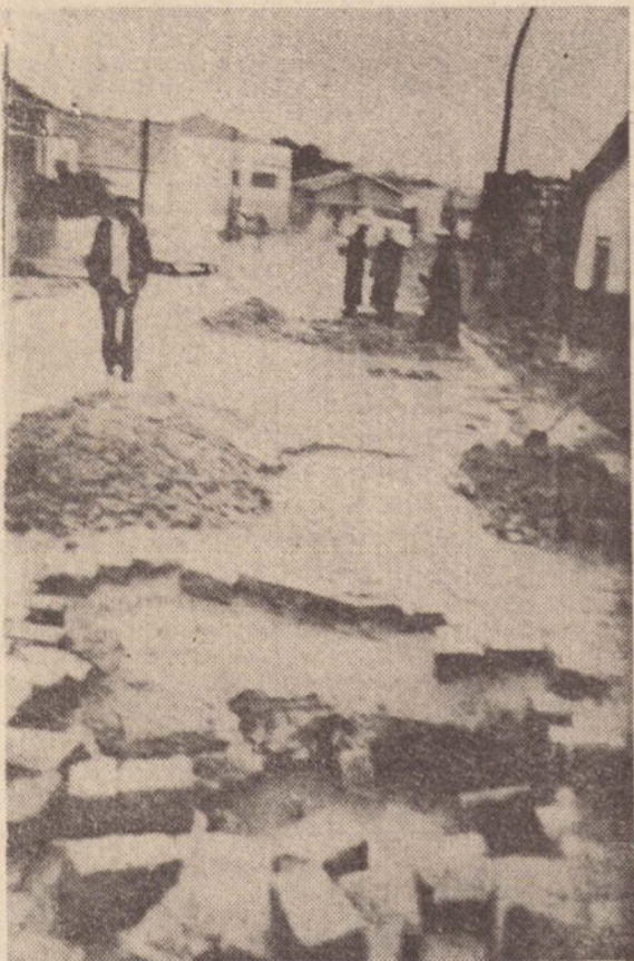
O vazamento na rede de abastecimento público foi uma das causas do desmoronamento do terreno
