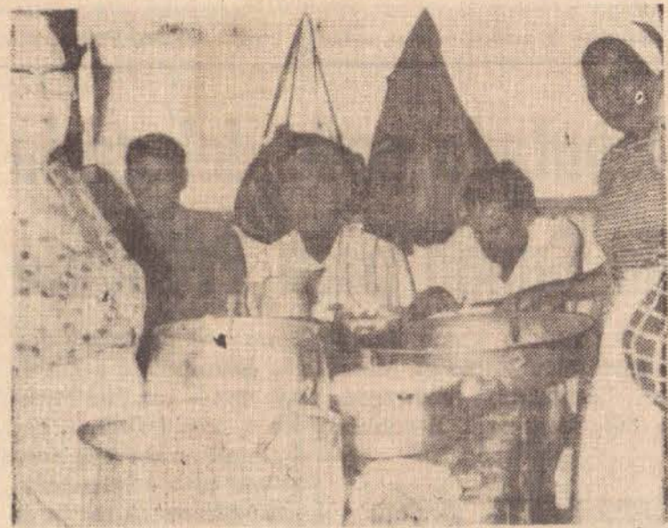
As refeições são servidas no local da obra, preparadas pelas esposas dos membros da Igreja.
