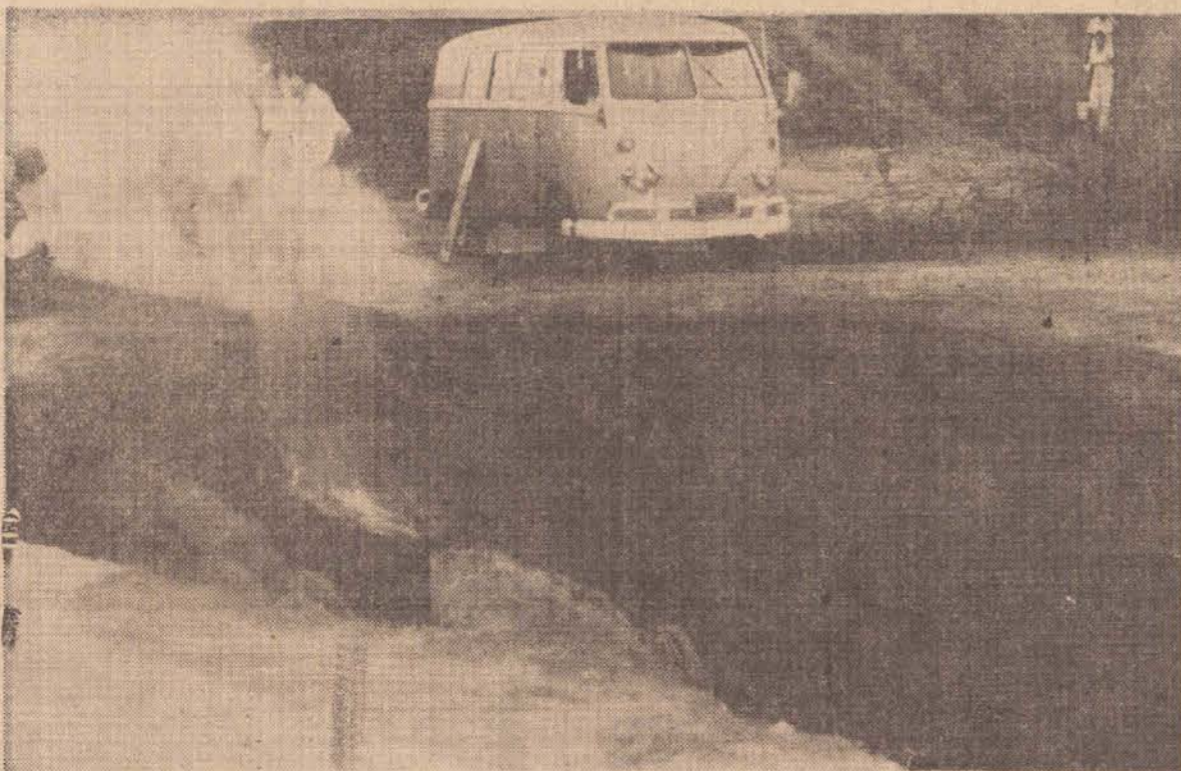
Por falta de proteção, toda a área em torno do poço está sendo erodida.
