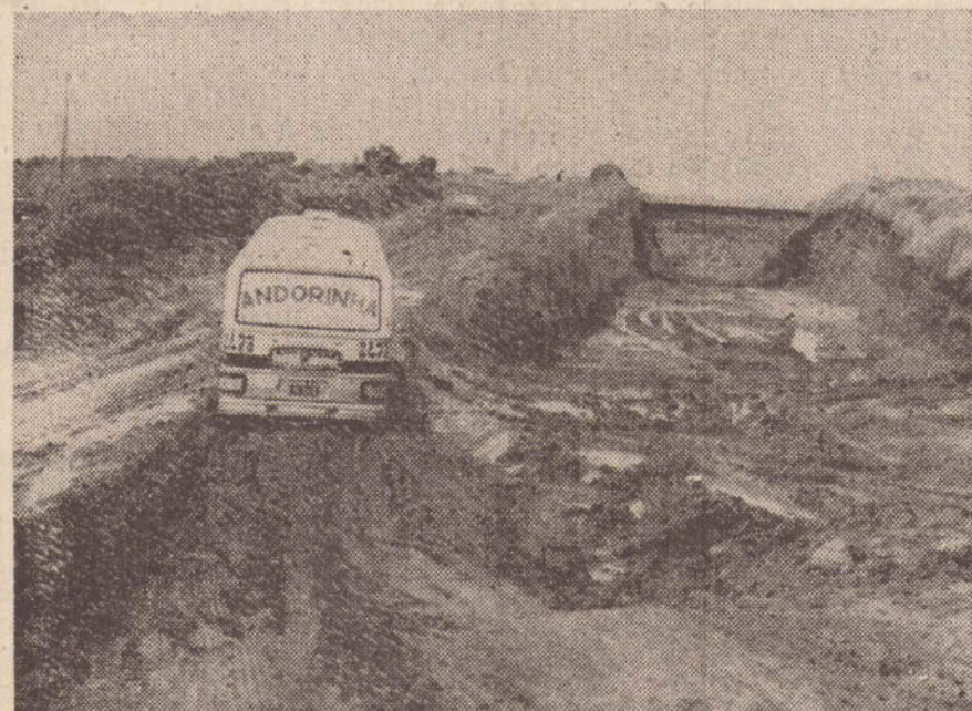
O trêvo não foi construído, a SP-425 está destruída num grande trecho não há acesso ao perímetro urbano de Pirapozinho. Chegar à rodovia Pirapozinho-Mirante é um suplicio para os motoristas.
