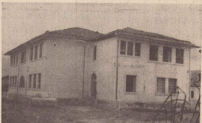
O 1.º Grupo Escolar está interditado. A paralisação nas obras da cobertura do edifício poderão comprometer a sua estrutura.
