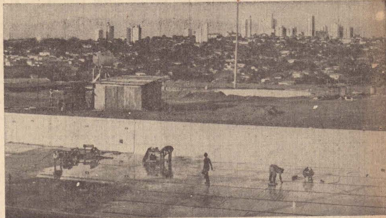
A piscina olímpica está em fase de acabamento.
