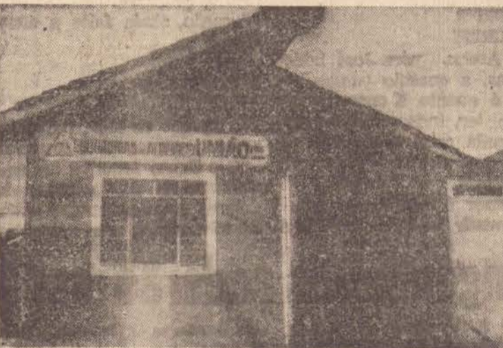
O escritório da Esquadrias de Alumínio União
