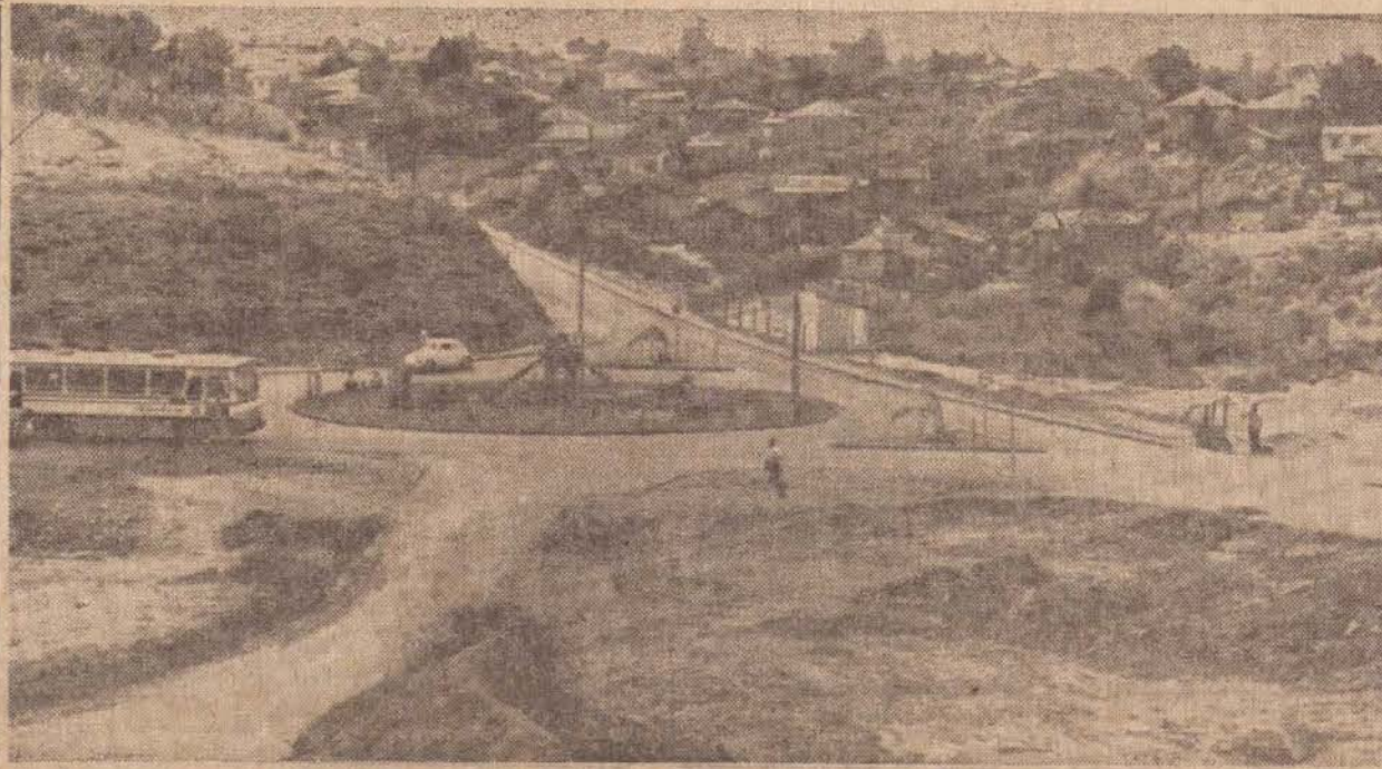
A praça rotatória após concluída pela Prudenco, já asfaltada.
