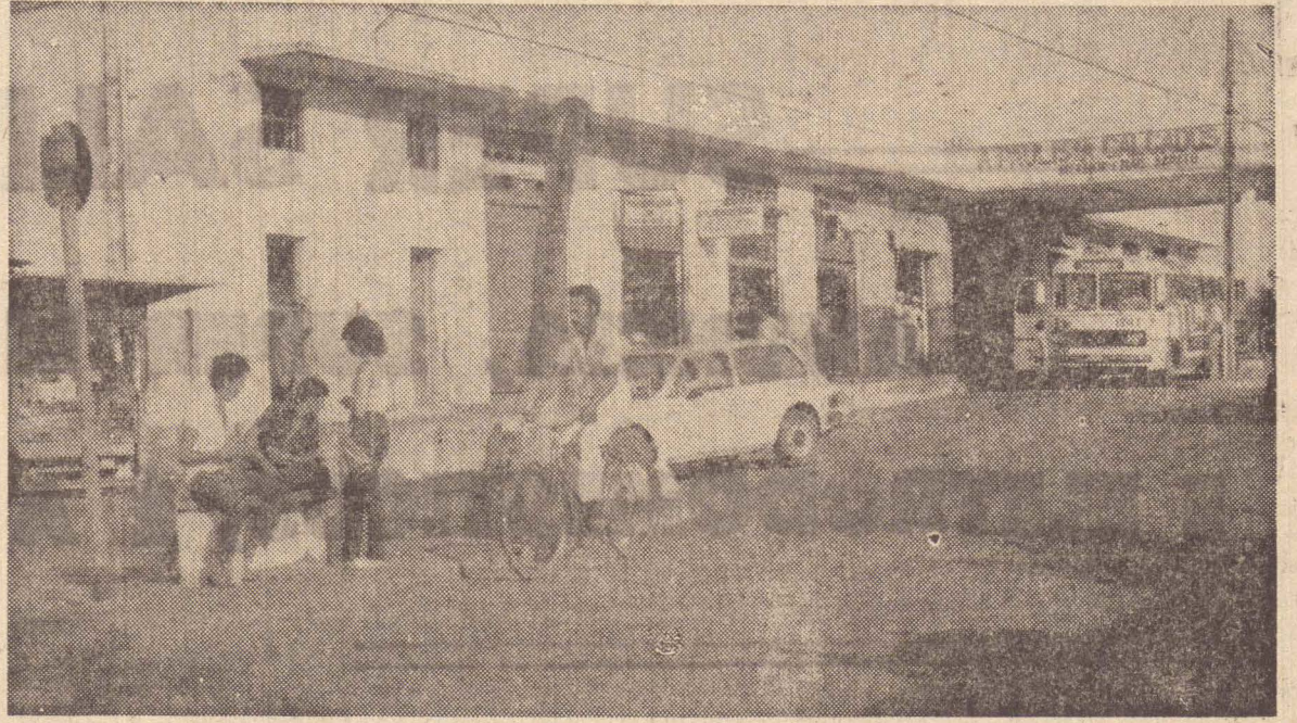
A estação rodoviária está em estado bastante precario. (Foto — Mauro L.T. Garrido.)
