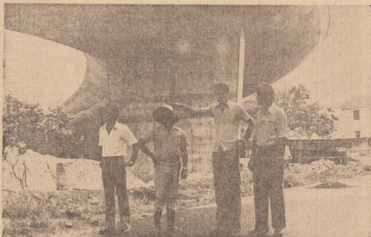
Prefeito e vice visitam as obras complementares do viaduto.
