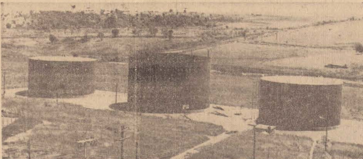
Numa altura equivalente a um prédio de 10 andares, a reportagem obteve esta fotografia, onde são vistos os tanques de armazenagem de álcool, com capacidade para 11 milhões de litros
