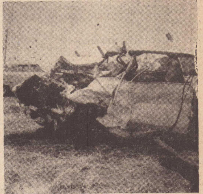
Uma vista lateral do veículo. Arregada toda a estampa frontal com total comprometimento da parte mecânica.
