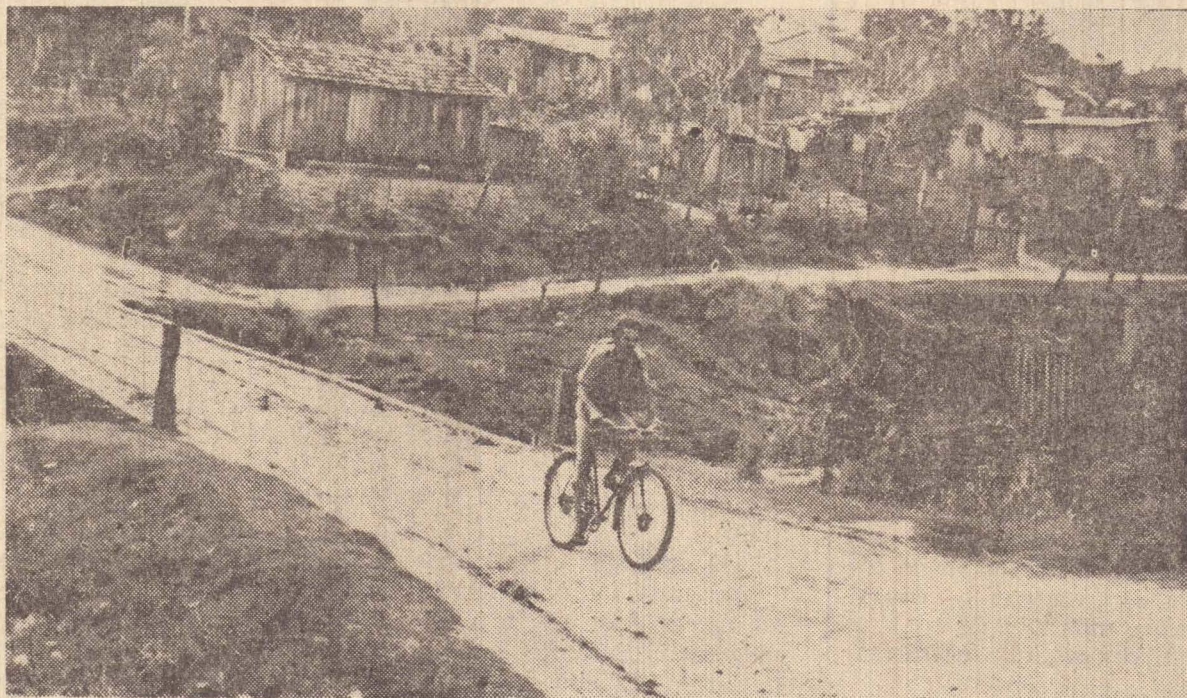
A ponte da "Vila do Remendo"
