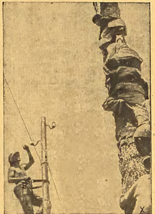
Kletterwettbewerb in der Cyrenaike: Palme gegen Telegrafmast. — Die „Strippenzieher“ einer Nachrichtenabteilung des Deutschen Afrika-Korps verlegen Kabel an den Strassen, über die endlose Nachschubkolonnen nach Osten fahren. Die kleinen braunen Söhne des Landes klettern eilig auf eine Palme und beobachten von hier aus mit neugierigen Augen jeden Handgriff des deutschen Soldaten aus nächster Nähe.
