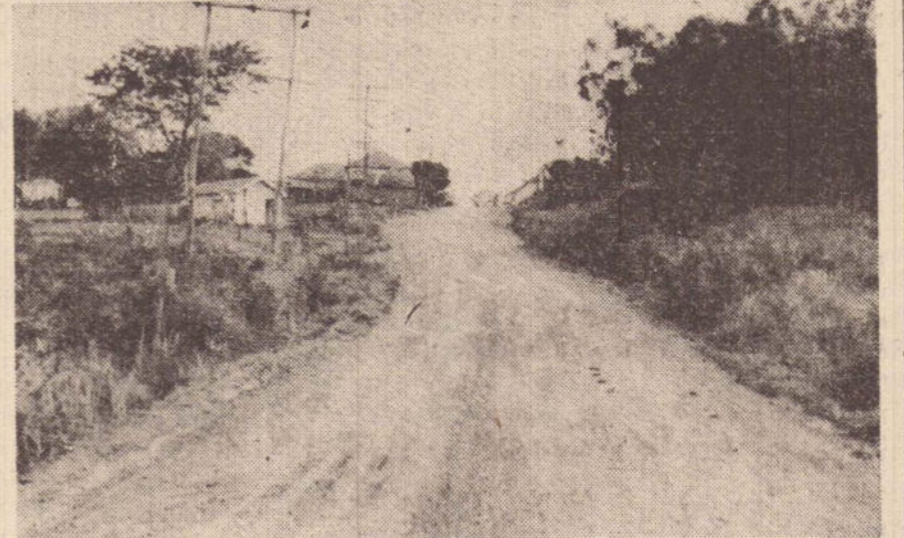
Com a colocação do cascalho a estrada oferece melhor condições de tráfego.
