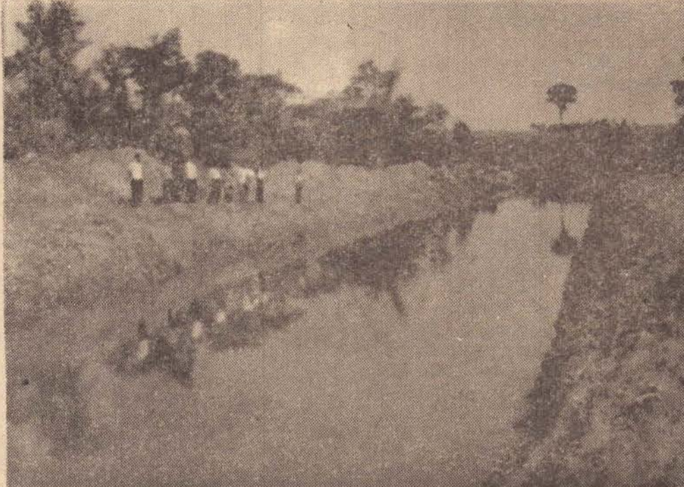
Para permitir o escoamento das águas nos períodos chuvosos foi necessário retificar um grande trecho do rio Santo Anastácio. Uma possante draga do D.N.O.S. (Depto. Nacional de Obras Sanitárias) está fazendo esse trabalho numa extensão de dois mil metros.
