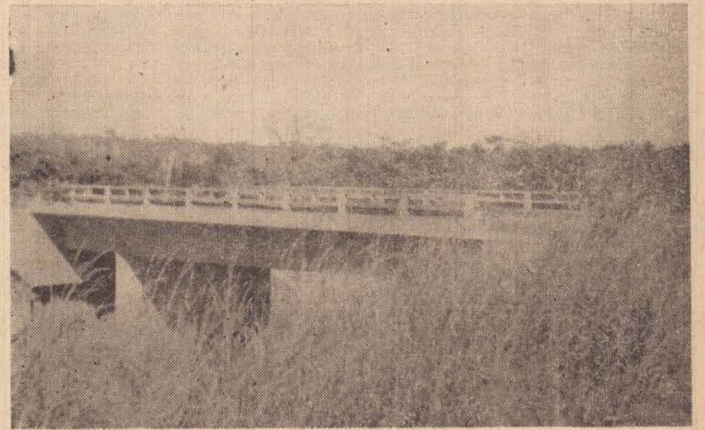
Outro aspecto da ponte que vai ligar Marabá Paulista aos municípios vizinhos. Note-se, que está praticamente concluída, devendo ser o ponto de convergência das riquezas da agricultura de Marabá Paulista aos centros consumidores.
