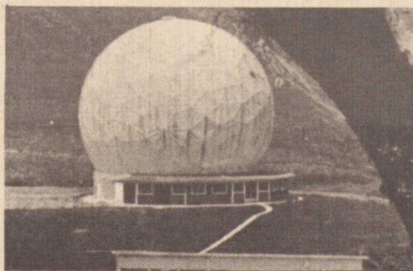
O CENTRO DE RÁDIO- ASTRONOMIA ITAPETINGA, EM ATIBAIA, PROCURA OBSERVAR O KOHOUTEK.
