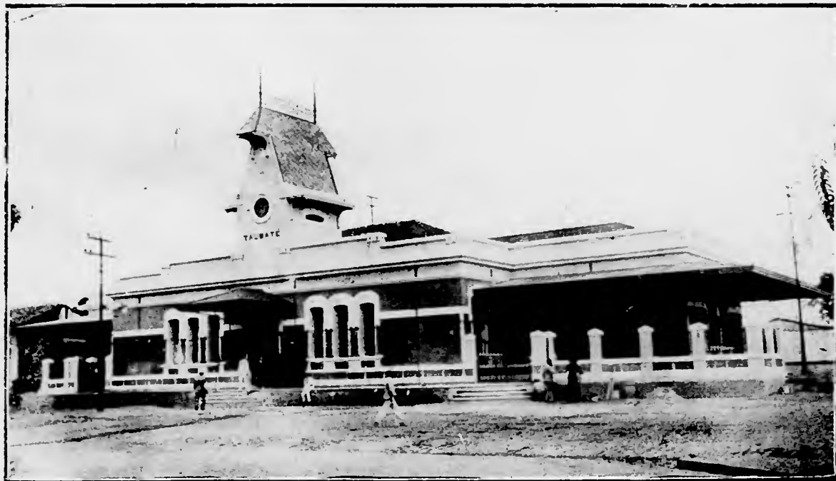
Um aspecto da entrada da nova estação da Estrada de Ferro Central do Brasil em Taubaté, construída pelos srs. V. De Finis & Cia.
