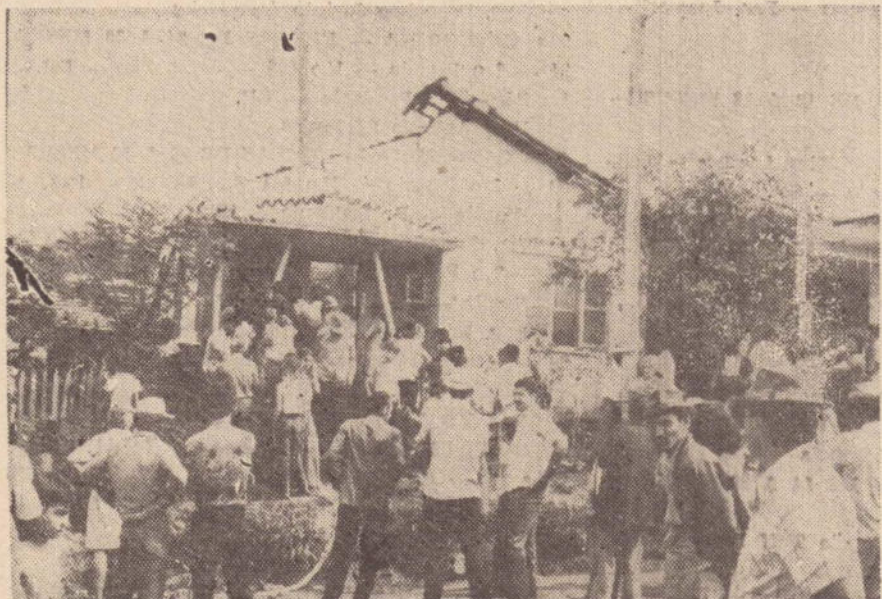
Dezenas de pessoas foram ver o incendio destruir a casa de D. Maria Dolores.
