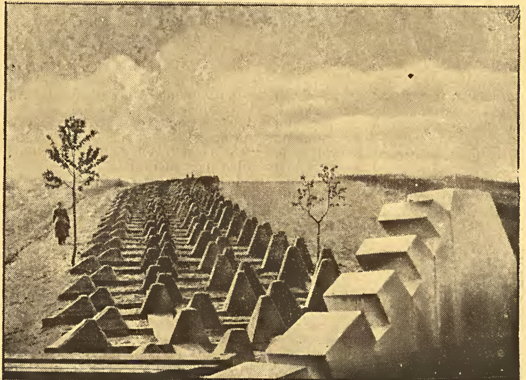
Vom Westwall des Reiches. — Längs der ganzen Befestigungsanlagen des Westwalls ziehen sich solche Höckerhindernisse, die kein Panzerwagen bezwingen kann.
