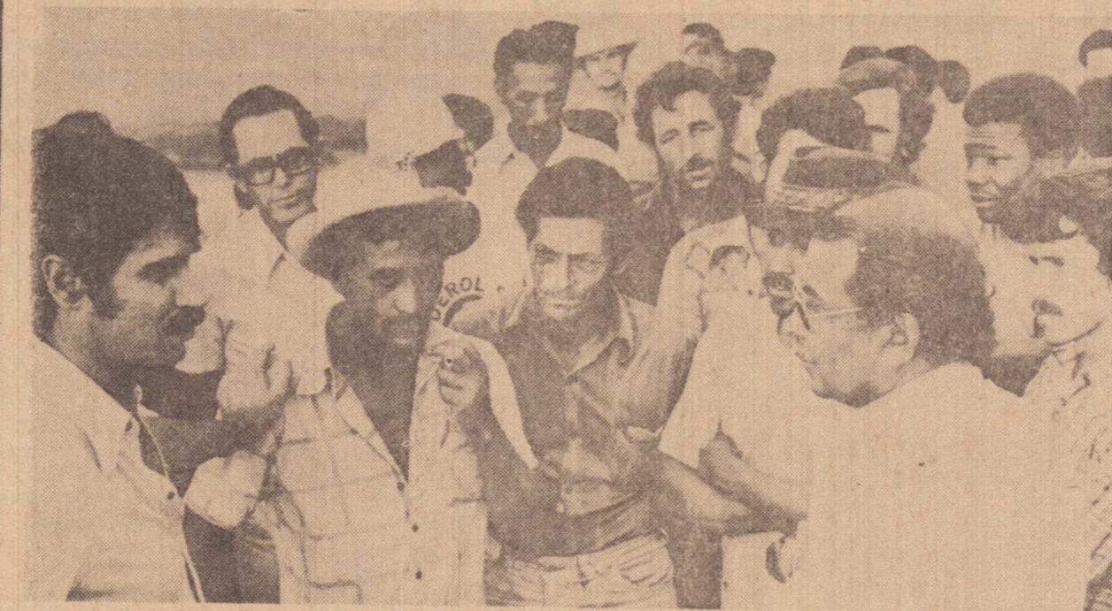
O prefeito entre os operários da Prefeitura e o popular Biguá que coordenou os trabalhos de construção da barragem.
