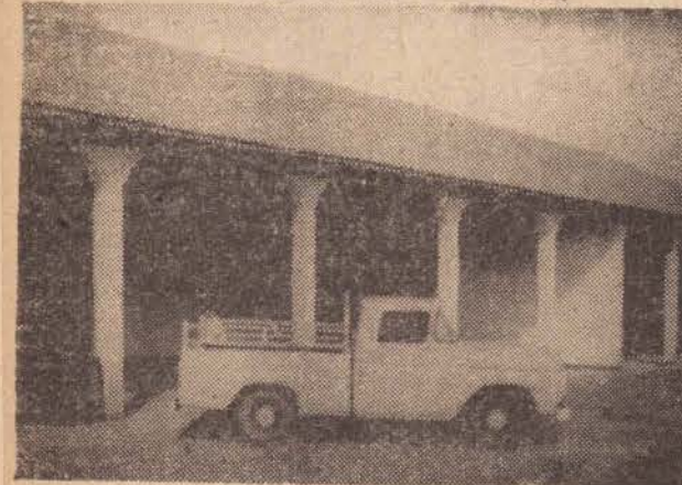
Moderna garagem da Prefeitura Municipal, concluída há algumas semanas, onde são guardados todos os veículos da Municipalidade.
