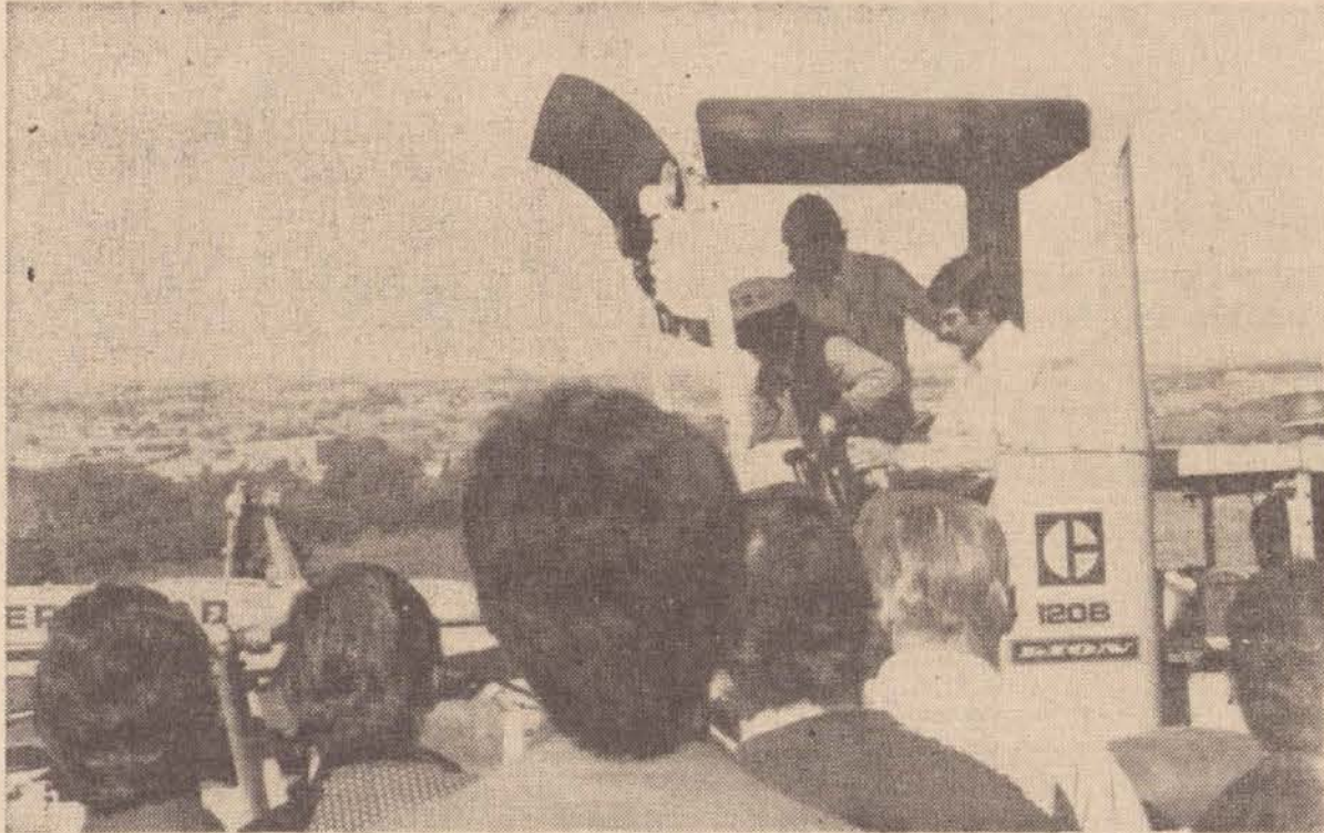
Ao volante de uma das máquinas, o prefeito inicia oficialmente as obras do Prudentão.
