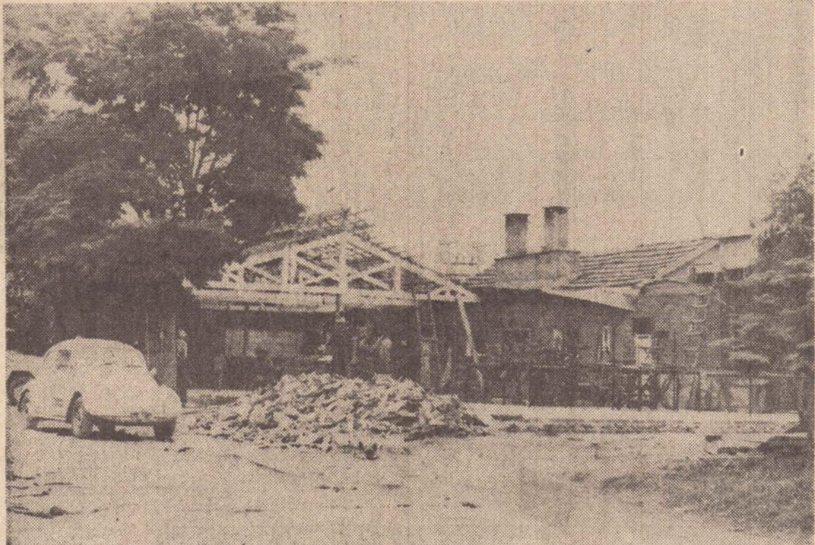
Teria havido uma pressão contra o telhado do restaurante, provocando o seu desabamento? Ninguém é capaz de afirmar isso com segurança.
