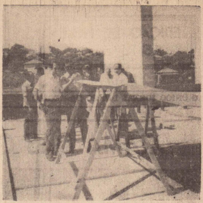
O prefeito eleito, Walter Lemes Soares, foi conhecer pessoalmente o andamento das obras do Novo Tennis Clube de Presidente Prudente. Aqui o novo alcaide está ouvindo dos srs. Hortencio Marini e Kazuo Fukuhara, explicações de como estão sendo colocadas as telhas que dão cobertura ao NTC.
